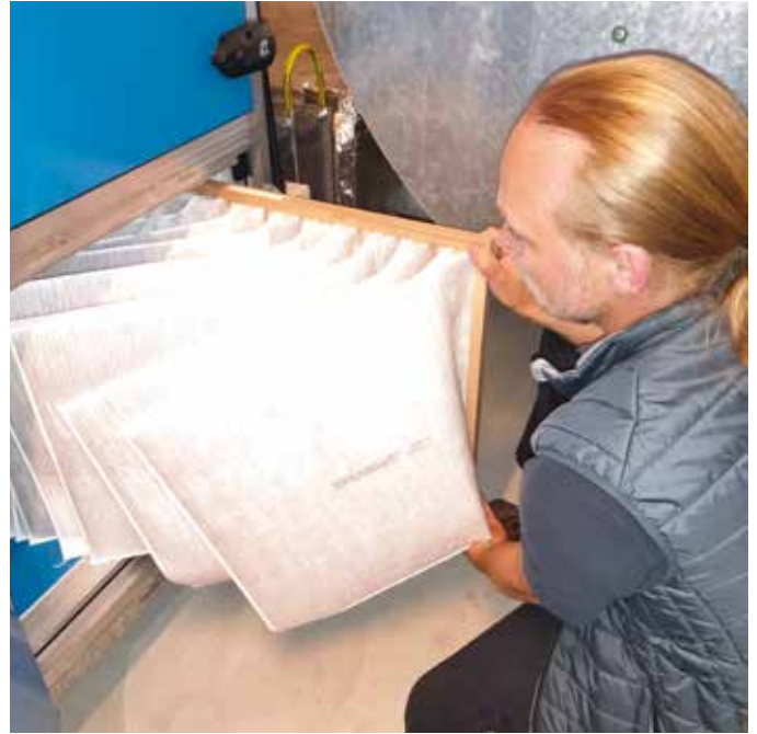
Wechseln des Luftfilters bei der Lüftungsanlage.
