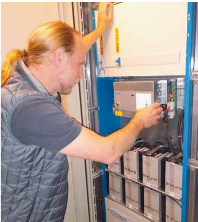
Kontrolle der Notbeleuchtung.
